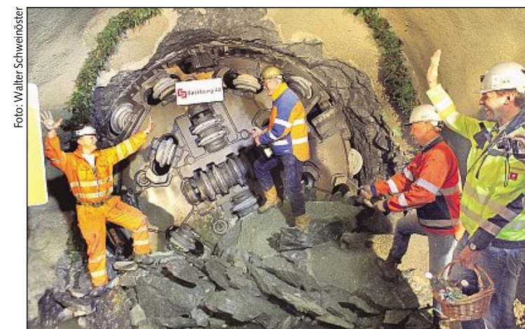
Der große Moment: Tunneldurchbruch im Kraftwerk Fusch
