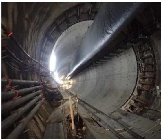
SBW Startröhre und Anfang Schildtunnel
