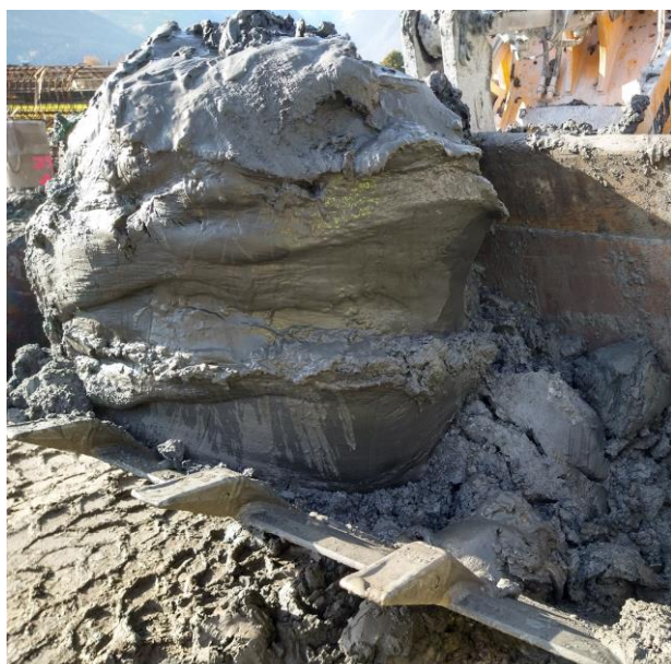
© iC/ Weicher, wassergesättigter Seeton beim Aushub der Bohrpfähle
