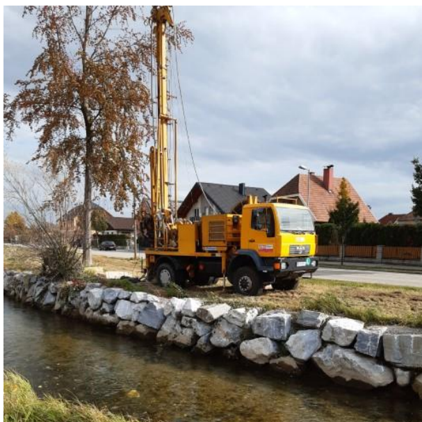
© iC/ Ausführung von Erkundungsbohrungen
