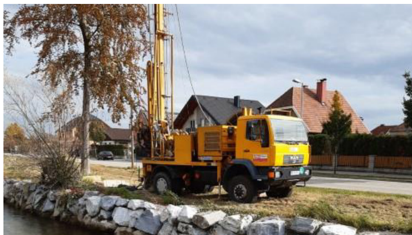
© iC group / Ausführung von Erkundungsbohrungen
