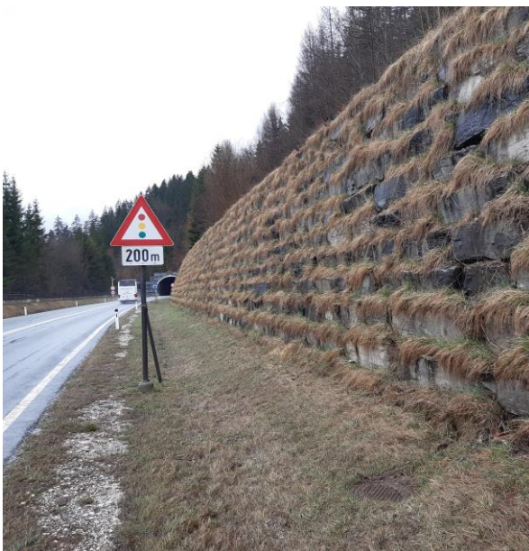
© iC/ Stützkonstruktion an der B178 vor dem Tunnel Lärchberg
