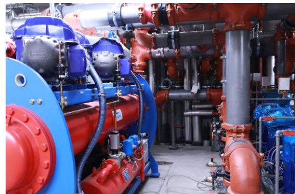
Generalsanierung UZA II Kälte
