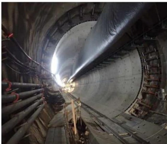
SBW Startröhre und Anfang Schildtunnel
