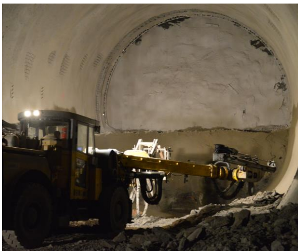
NÖT – Vortrieb Haupttunnel mit kurzem Ringschluss
