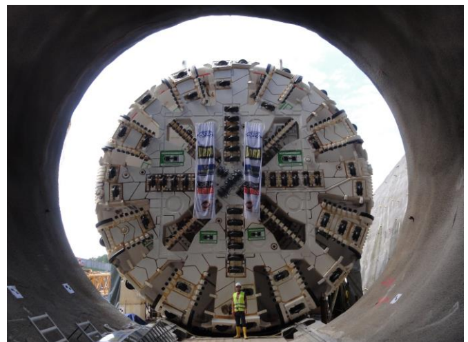
Tunnelvortriebsmaschine am Portal Aichelberg
